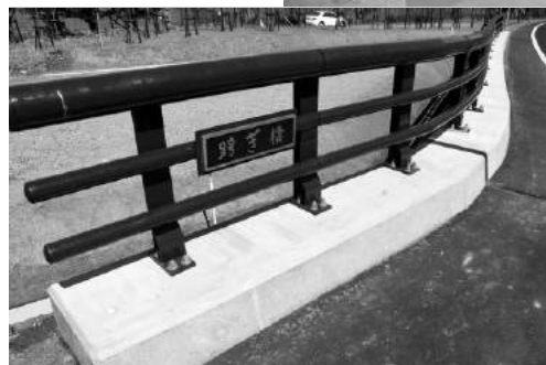
東湖畔側には4月号で紹介した橋名板も設置されています
