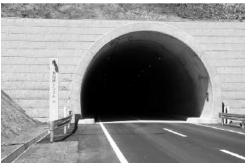
東湖畔トンネル
