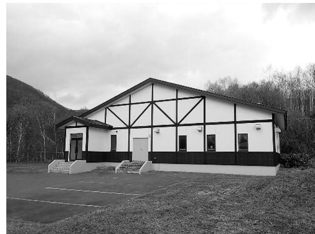
仲洞爺地区農業集落排水処理施設
