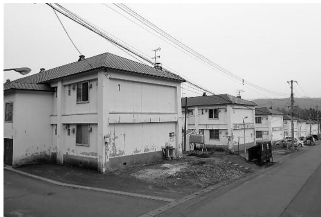
建部改良住宅
