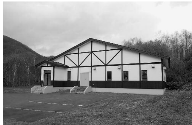
仲洞爺地区農業集落排水処理施設
