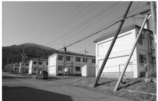
建部改良住宅
