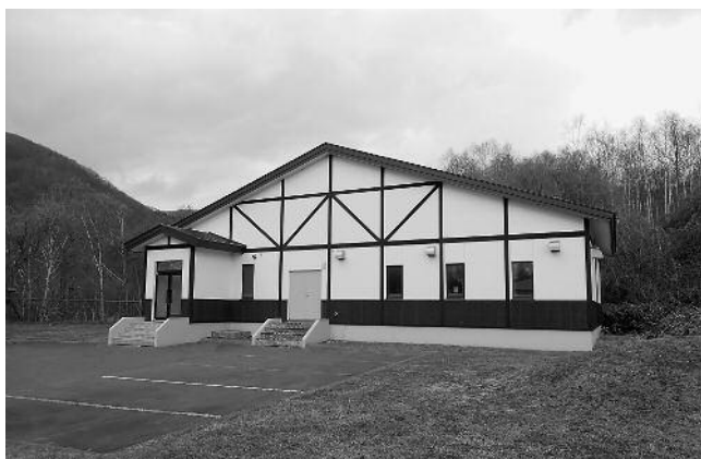
仲洞爺地区農業集落排水処理施設
