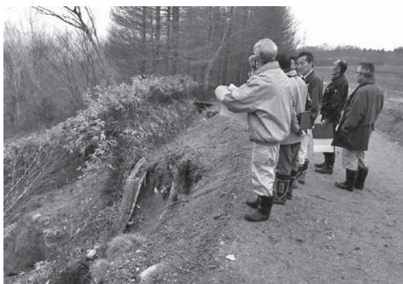
上久保内牧場からの排水路路肩崩落箇所
