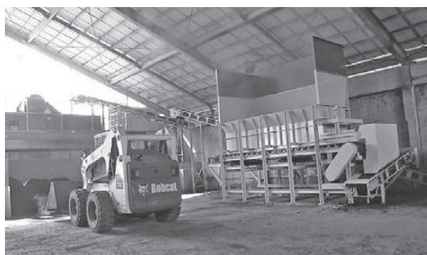
更新された堆肥センターふりい機
