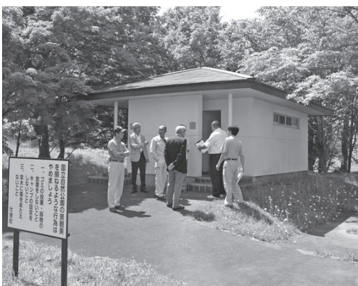
公衆トイレ現地視察の状況
