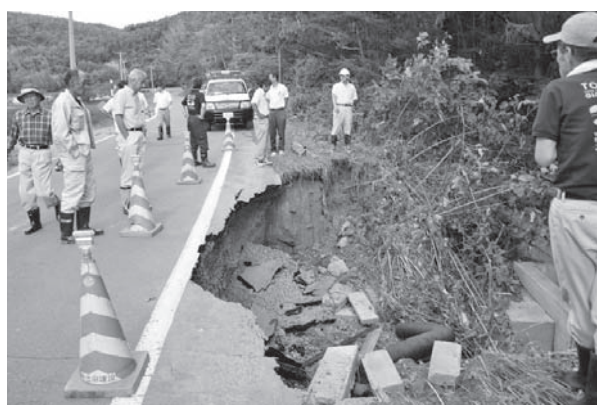
町道上久保内蟠溪線路肩崩落現場
