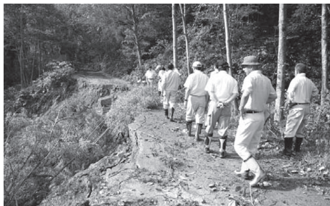
駒別林道崩落現場
