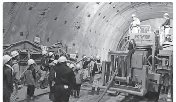
道道東湖畔トンネル工事見学会の様子
