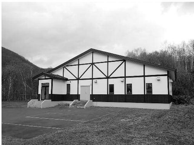
仲洞爺地区農業集落排水処理施設
