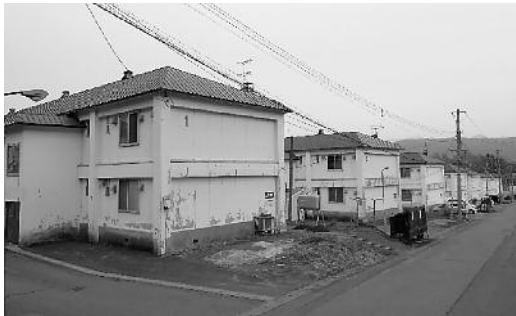
建部改良住宅
