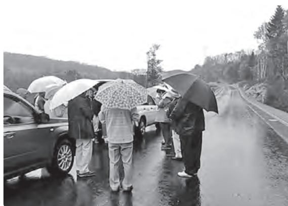
道道滝之町伊達線の工事状況
