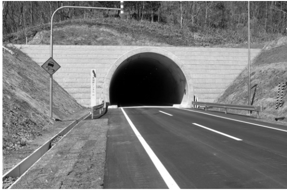
道道東湖畔トンネル開通
