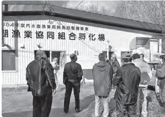
仲洞爺孵化場 屋根等大規模改修工事後の状況
