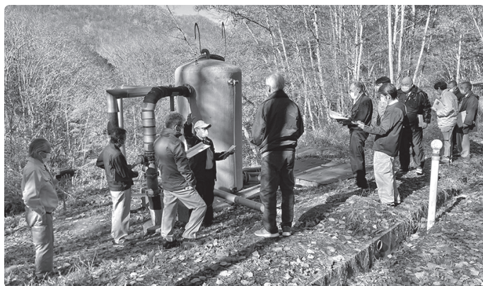
弁景温泉供給設備の状況
