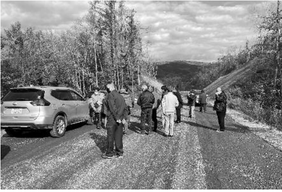
道道滝之町伊達線工事の進捗状況
