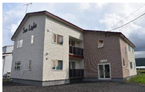
■H27 に助成を受け建設された民間アパート
